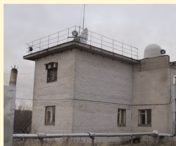
Здание АЭ Архангельск с установленной антенной МАРЛ-А
