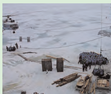
Работы на льду
