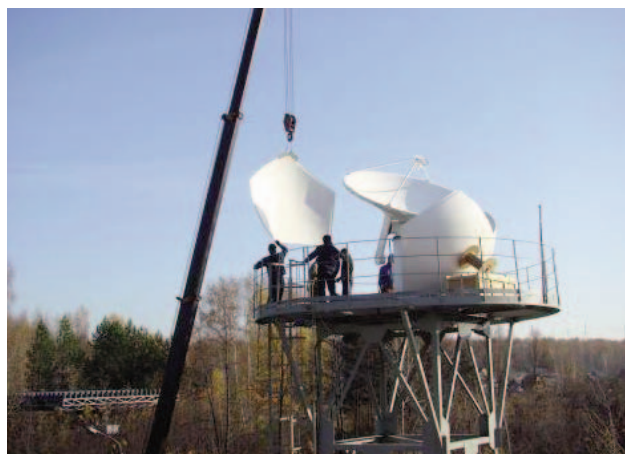
Монтаж антенных комплексов "Kongsberg"
