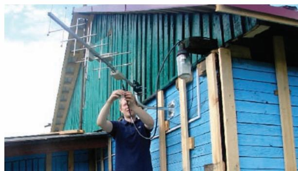
Монтаж радиотерминала на М2 Архангельск (Северное УГМС)
