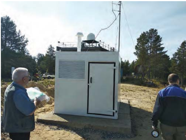
Ввод в эксплуатацию воздухофильтрующей установки в г. Кандалакша Мурманской области
