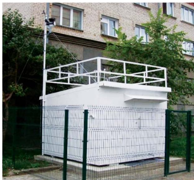
Пункт наблюдения за загрязнением атмосферного воздуха после модернизации
