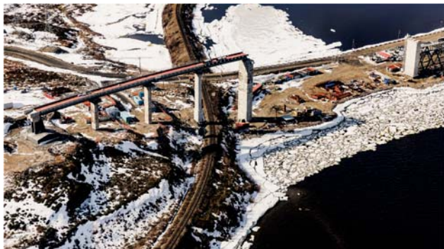
Строительство сооружений Морского торгового порта «Лавна»
